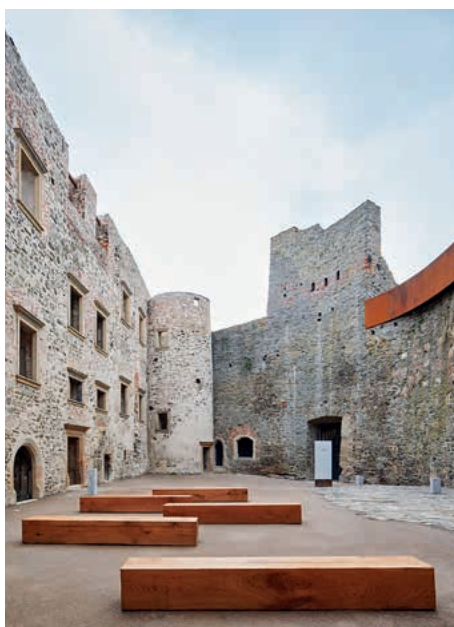
↑ Rekonstrukce hradu Helfštýn – pohled do čtvrtého nádvoří (foto Studio BoysPlayNice)
